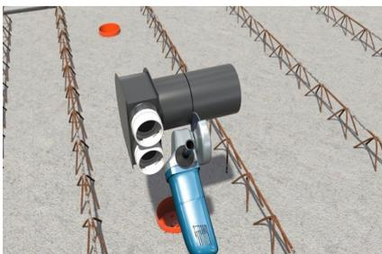
Lüftungsverteiler auf passende Länge kürzen.
