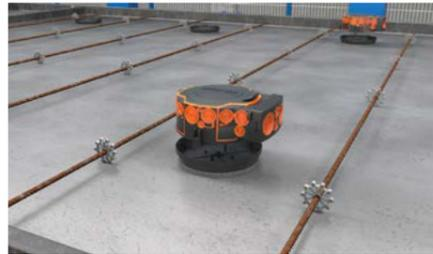
Einbaugehäuse wird aufgesetzt.
