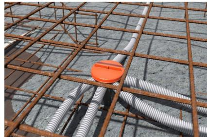
Deckel auf den Dosenkörper schrauben, zweite Stahlarmierung legen und betonieren.
