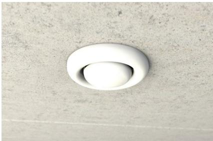
Lüftungsauslässe montieren. Durch integrierte und genormte Schraubdomes auch andere Auslassformen möglich.
