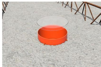
Schutzdeckel der Lüftungshülse entfernen.
