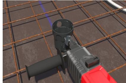
Einführungen für Installationsrohre M20/M25 mit einem Stufenschälbohrer oder einer Stanzzange öffnen.
