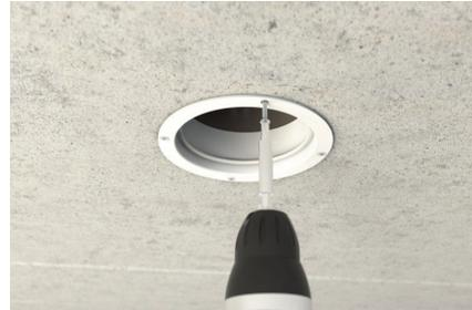
Adapterring an die Lüftungshülse schrauben.
